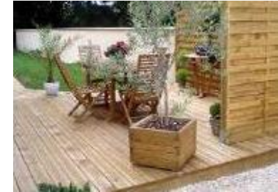
Terrasse en lames de bois sur structure drainante
