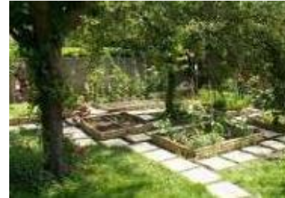
Dallage posé sur sable
