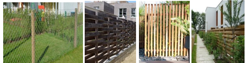
Grillage métallique sur poteaux bois et clôtures bois à claire-voie (ajourée)
