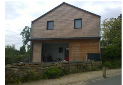
Muret pierre en façade
