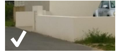
Muret enduit en façade
